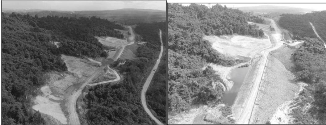
Gambar 6. Contour Drain 3 dan 4 yang menuju ke kolam pompa 3 (kiri) Kolam pompa 3 sudah on grade di RL 36.00 (kanan).
