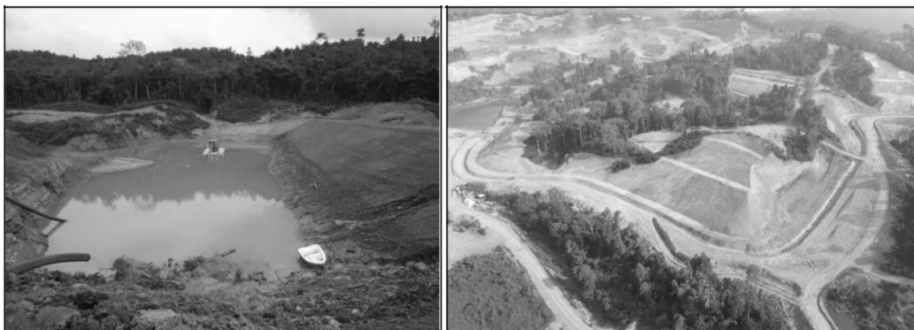
Gambar 5. Kolam Pompa 1 sudah selesai dikerjakan lengkap dengan pompa sekelas MF 390 (kiri). Contour Drain dengan perkuatan tyre drop structure untuk meredam energi air (kanan).
