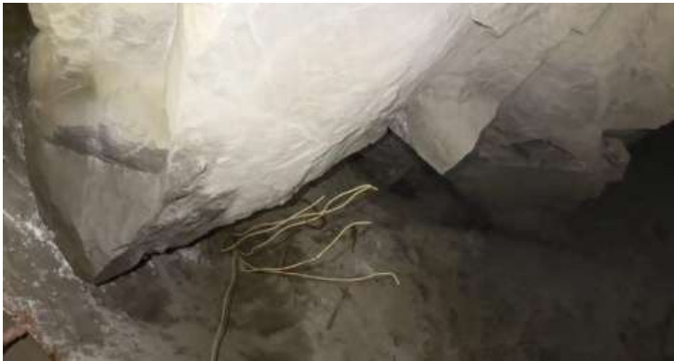
Gambar 7 Hasil Inspeksi Visual batuan menggantung pada Drawpoint Produksi
