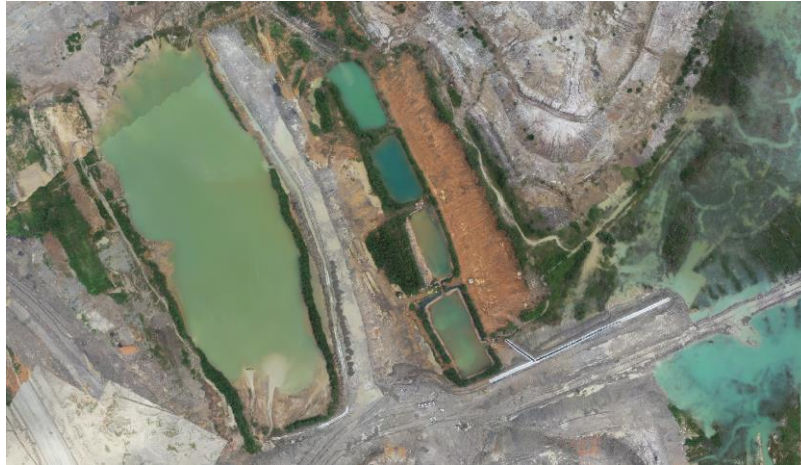
Gambar 11. Progress Pembentukan Subdrain di Area Sedpond 01
