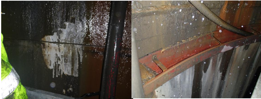
Gambar 7. Pemotongan dinding concrete shaft (kiri); Pemasangan pengait ( brace ) (kanan)
