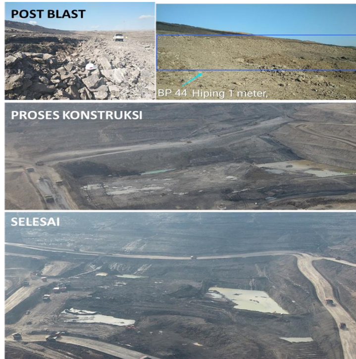
Gambar 8. Kegiatan konstruksi rubble road
