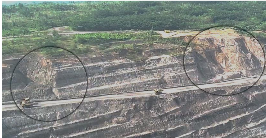
Gambar 3. Longsor yang terjadi akibat overcut terhadap desain
